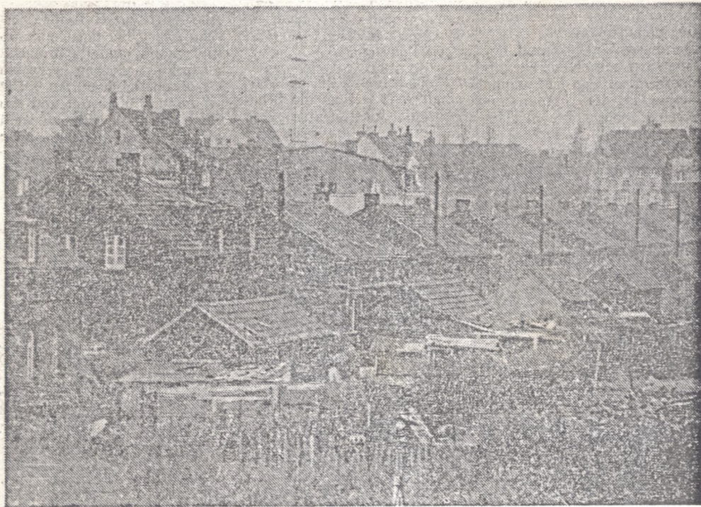
VOR DER DEM BEGINN DER SANIERUNG bot die Arbeitersiedlung Eisenheim ein nicht gerade hübsches Bild. Inzwischen haben die Arbeiten begonnen. waz-Bilder: Ruth Gläser
